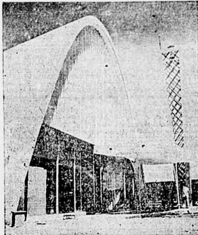
Entrada da Igreja da Pampulha, fotografada quando ainda em construção
