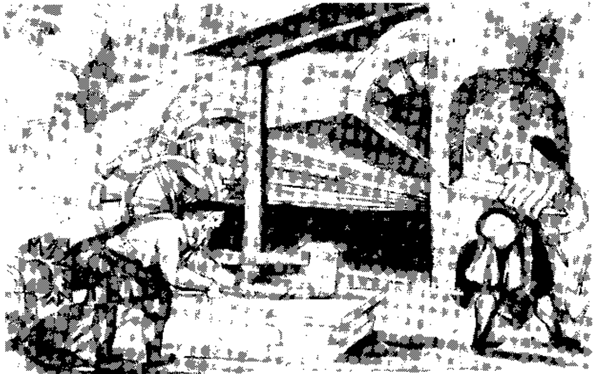
蒂罗尔的机械化锻铁：鼓风机和锻锤由一个水轮带动， 图前方系凸轮轴（十六世纪），维也纳奥地利国立图书馆 图片部。
